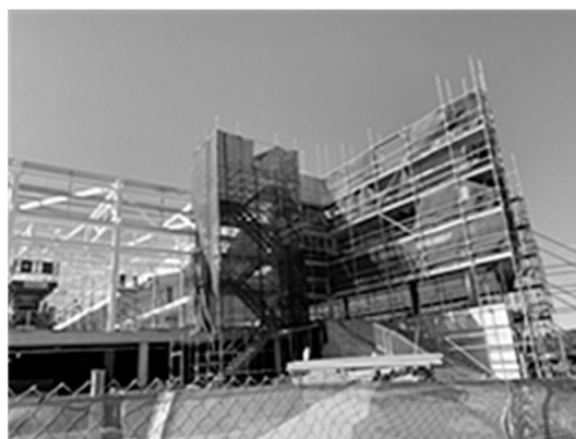
建設中の体育館と教室
