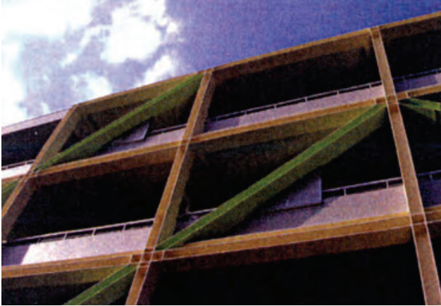
突起物のない鉄骨とセーフティパネル
