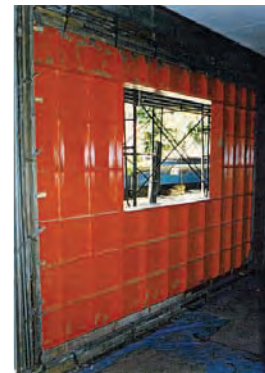
鋼板壁補強
