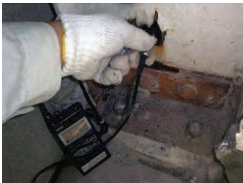
板厚の測定状況
