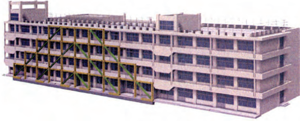
南側外観バース（バルコニーの外側に配置したブレース形状）
