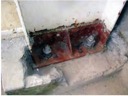
鉄骨柱脚の研り調査
