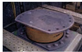
5階柱頭免震装置据え付け
